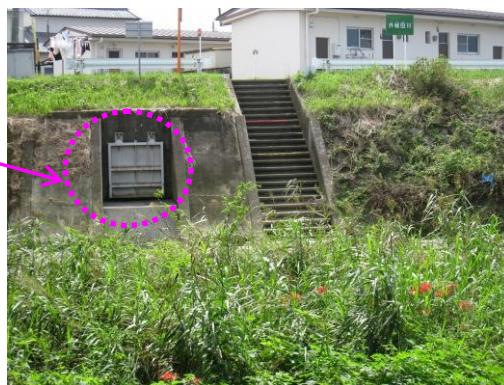
樋門・樋管の逆流対策の例
